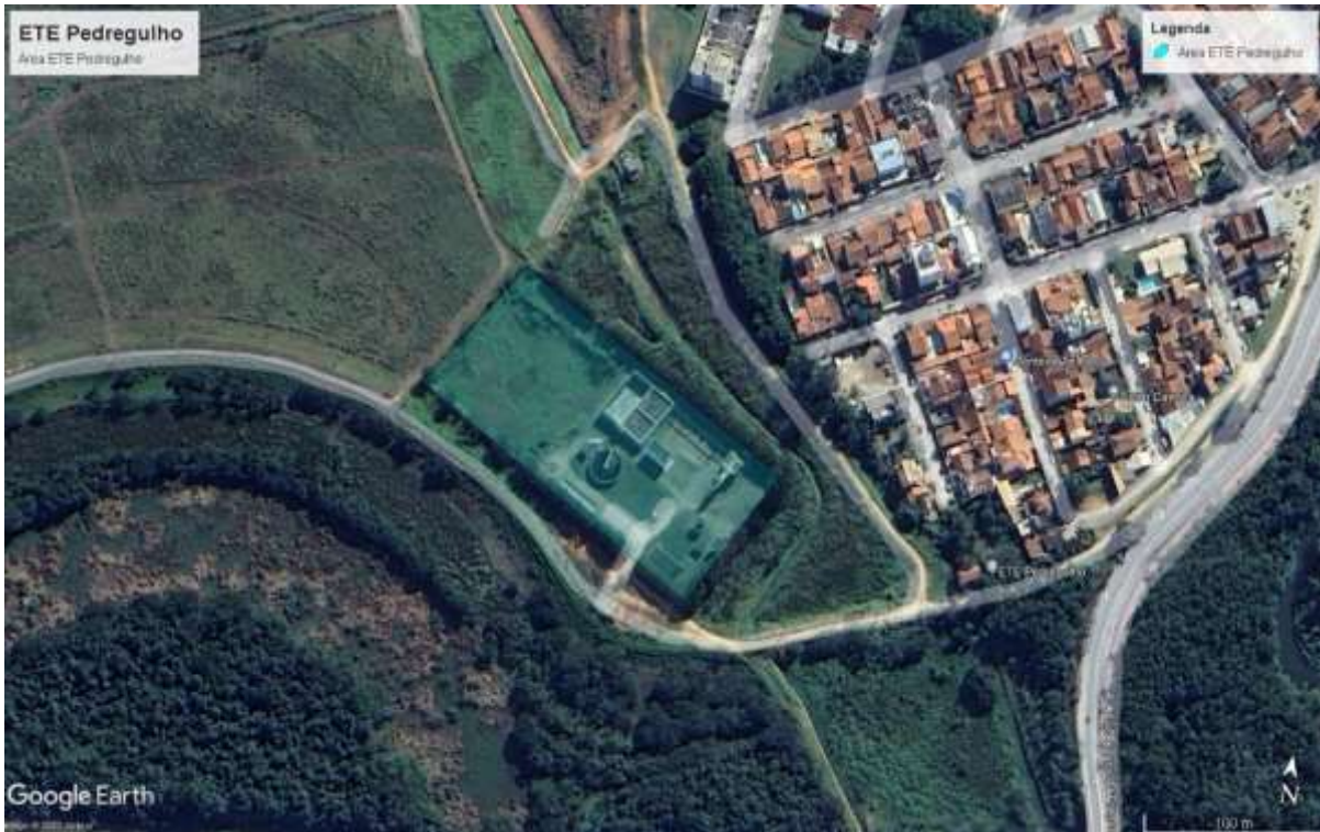
Figura 1: Localização ETE Pedregulho
