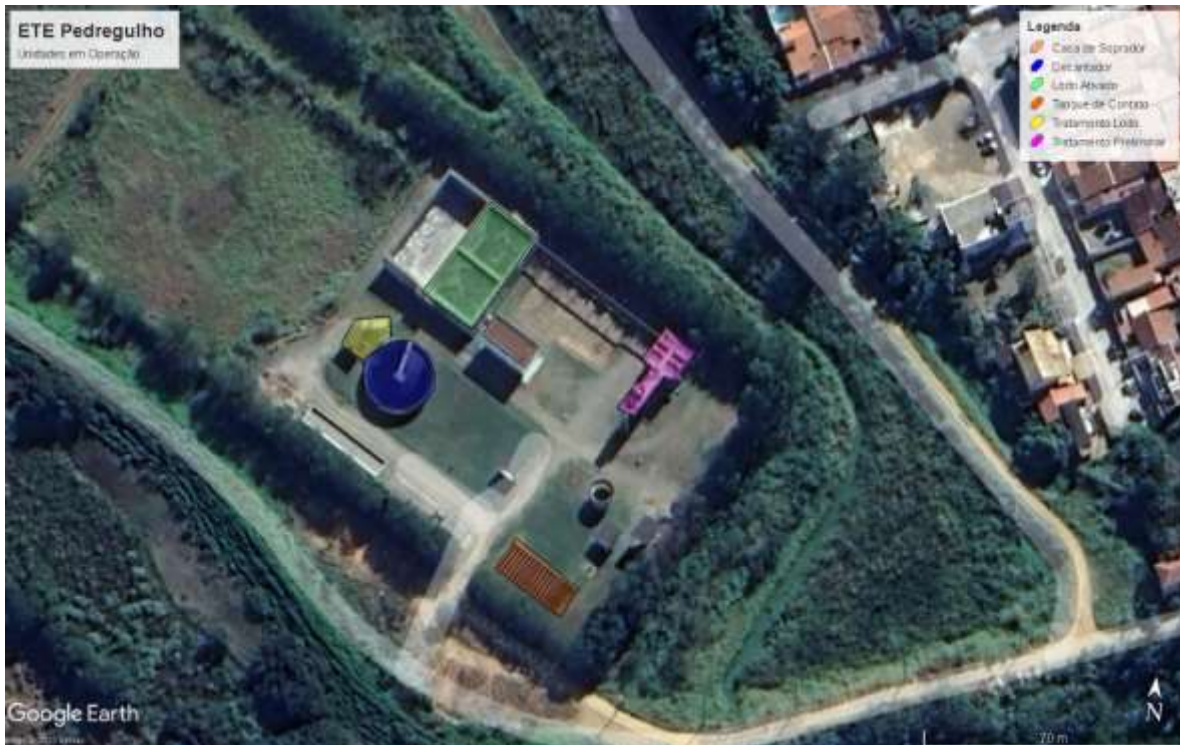
Figura 2: Unidades em operação - ETE Pedregulho
