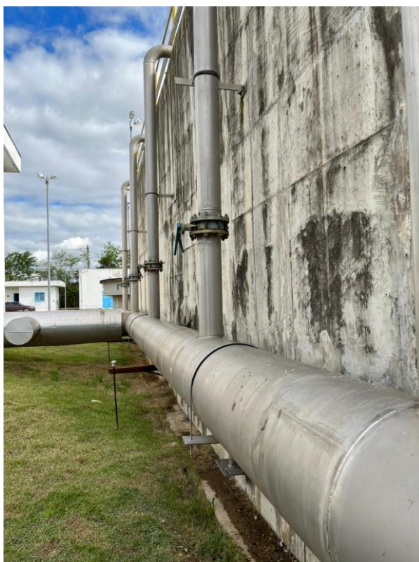
Figura 18: Tubulação de Ar Soprado, que vai para o Tanque de Aeração de Lodo Ativado
