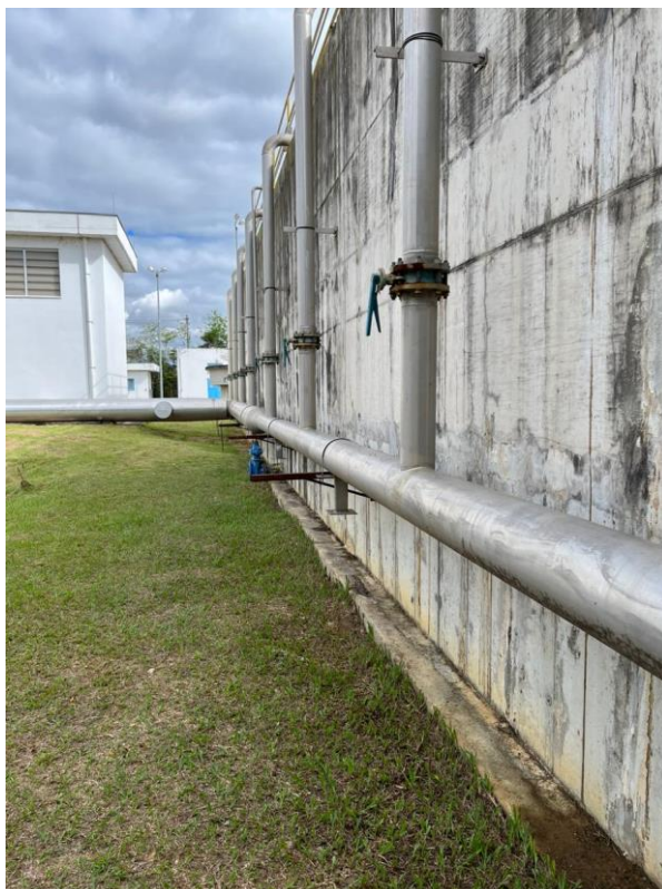
Figura 17: Tubulação de Ar Soprado, que vai para o Tanque de Aeração de Lodo Ativado
