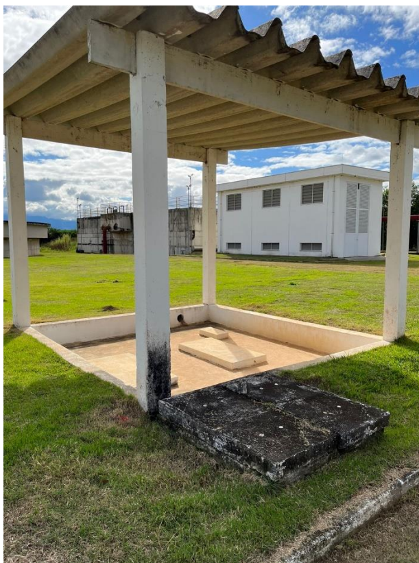
Figura 38: Base de Bombas Padrão Executada, que deverá ser executada para outras bombas previstas
