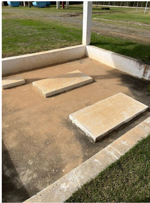
Figura 39: Base de Bombas Padrão Executada, que deverá ser executada para outras bombas previstas
