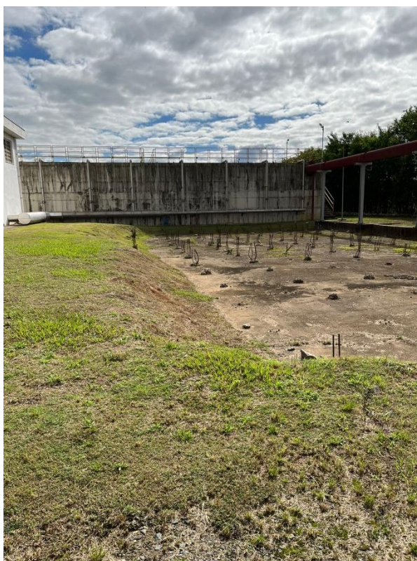
Figura 25: Local da Futura Casa de Desidratação, com estacas já executadas (Ver Projeto Pina)
