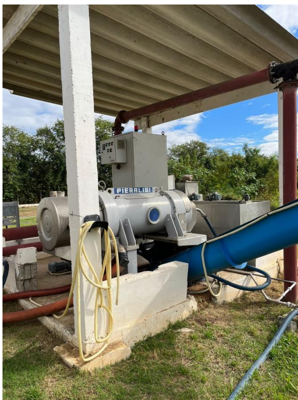
Figura 31: Centrífuga Existente a ser remanejada
