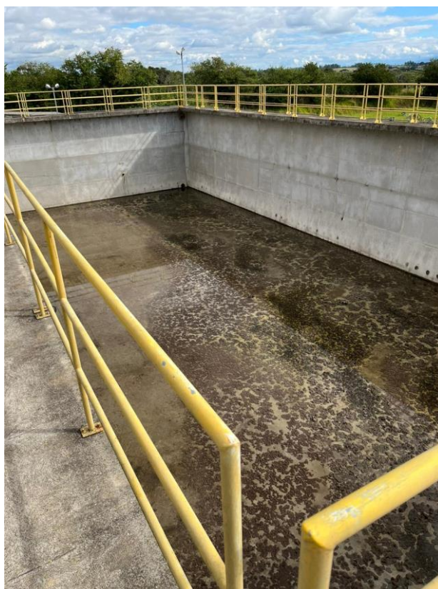
Figura 11: Digestor de Lodo
