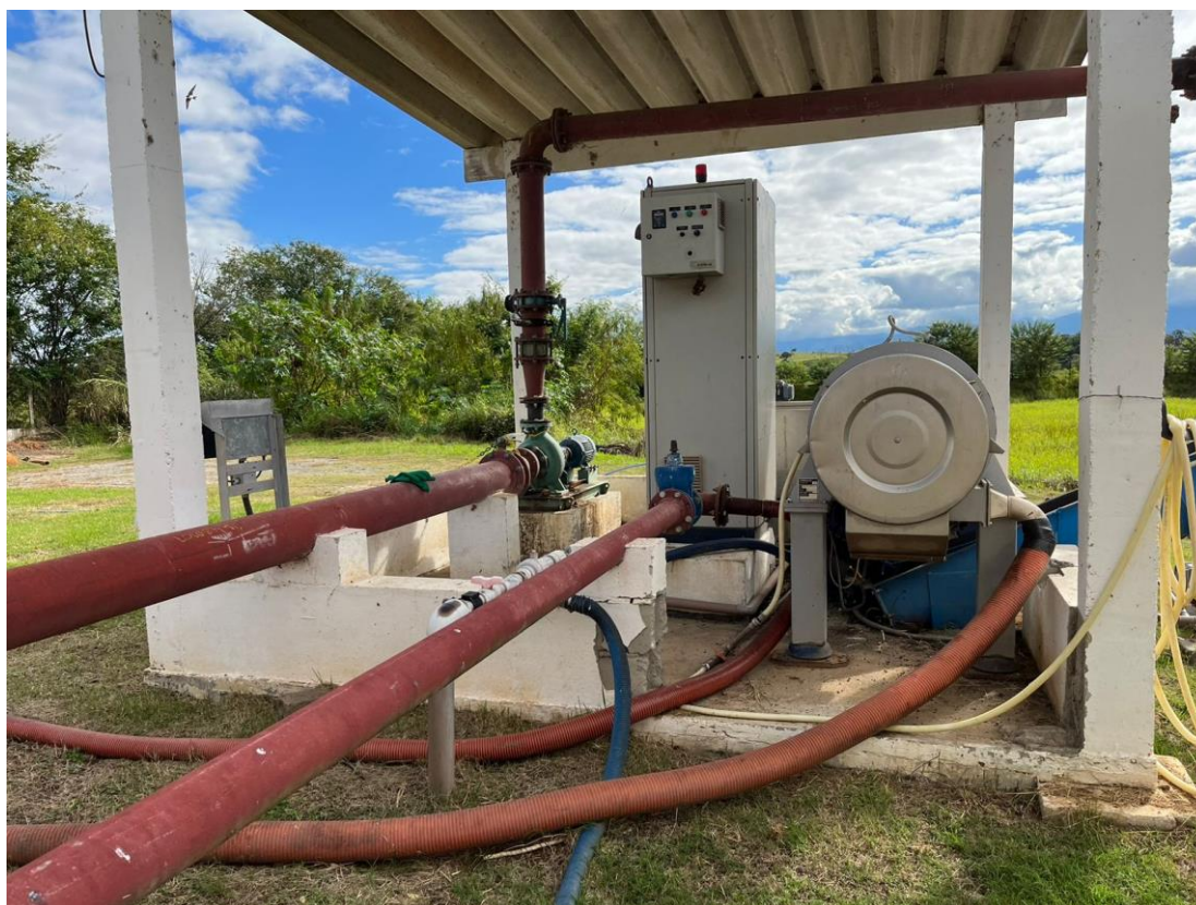
Figura 30: Centrífuga Existente a ser remanejada
