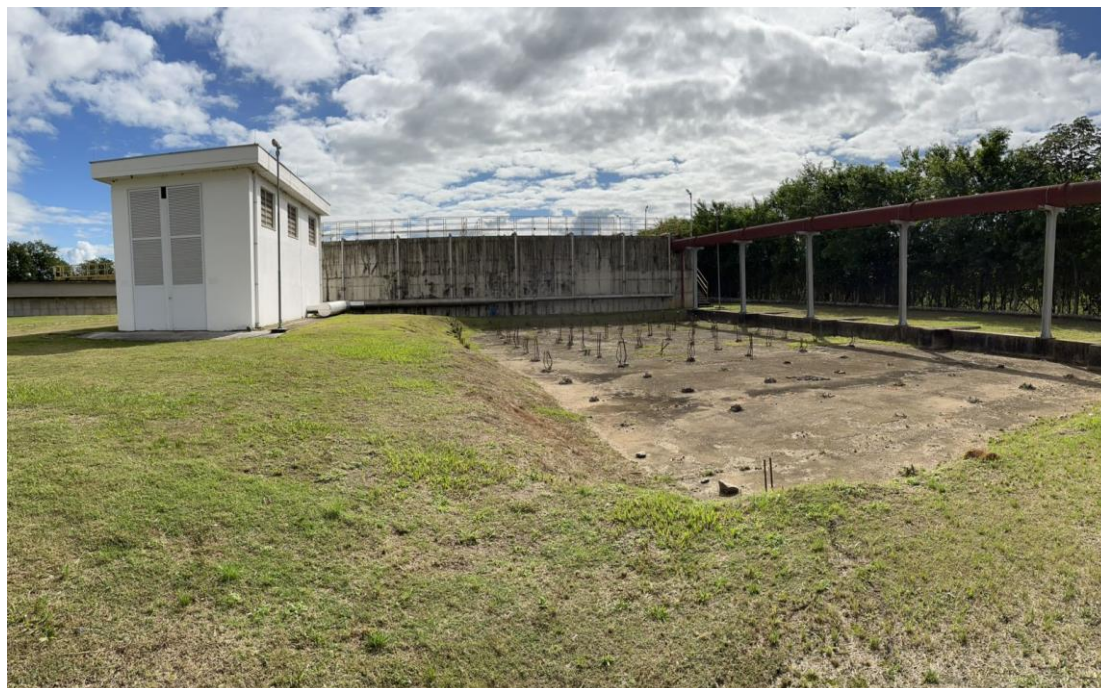
Figura 24: Local da Futura Casa de Desidratação, com estacas já executadas (Ver Projeto Pina)
