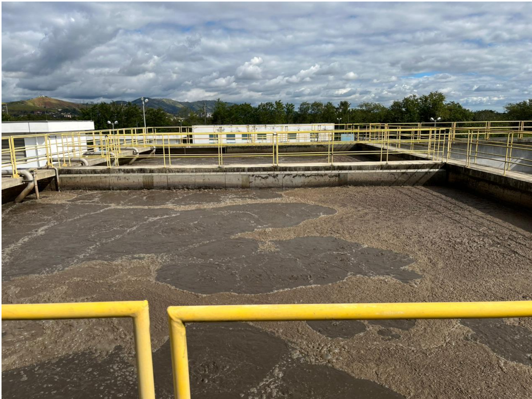
Figura 8: Tanque de Aeração (Lodo Ativado)
