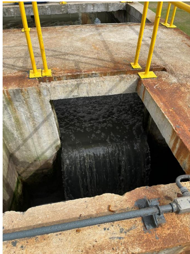
Figura 6: Sáida de Efluente da Caixa de Areia
