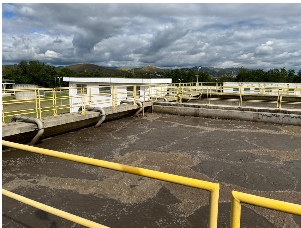
Figura 9: Tanque de Aeração Lodo Ativado
