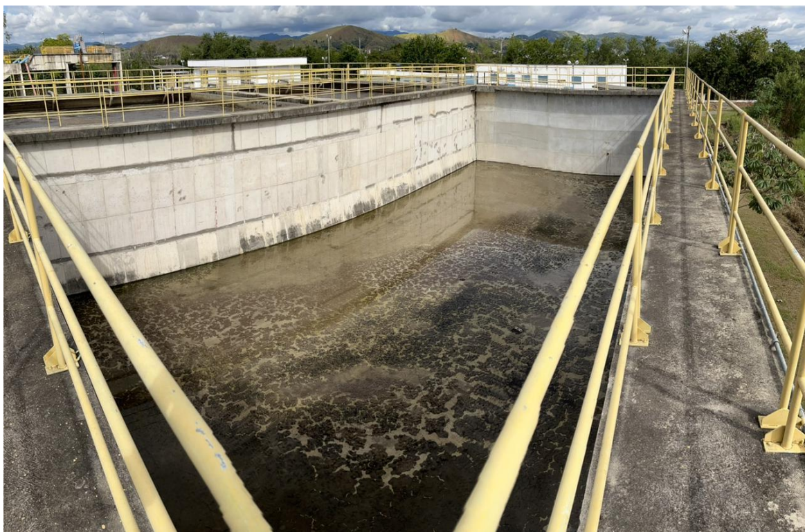
Figura 12: Digestor de Lodo
