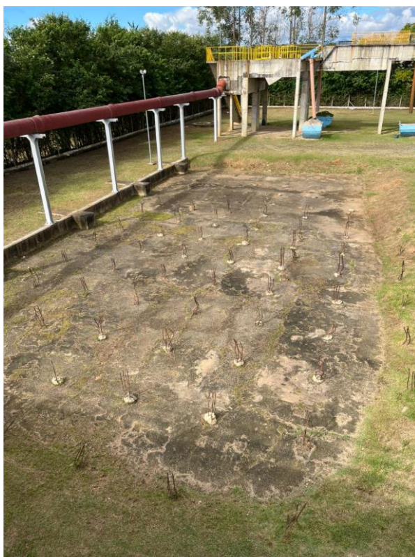
Figura 26: Local da Futura Casa de Desidratação, com estacas já executadas (Ver Projeto Pina)
