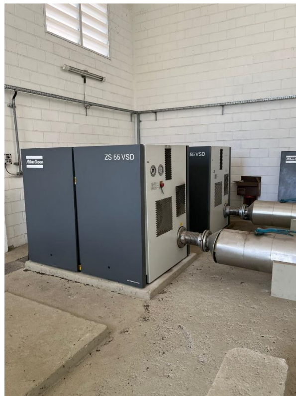
Figura 22: Sopradores em Operação
