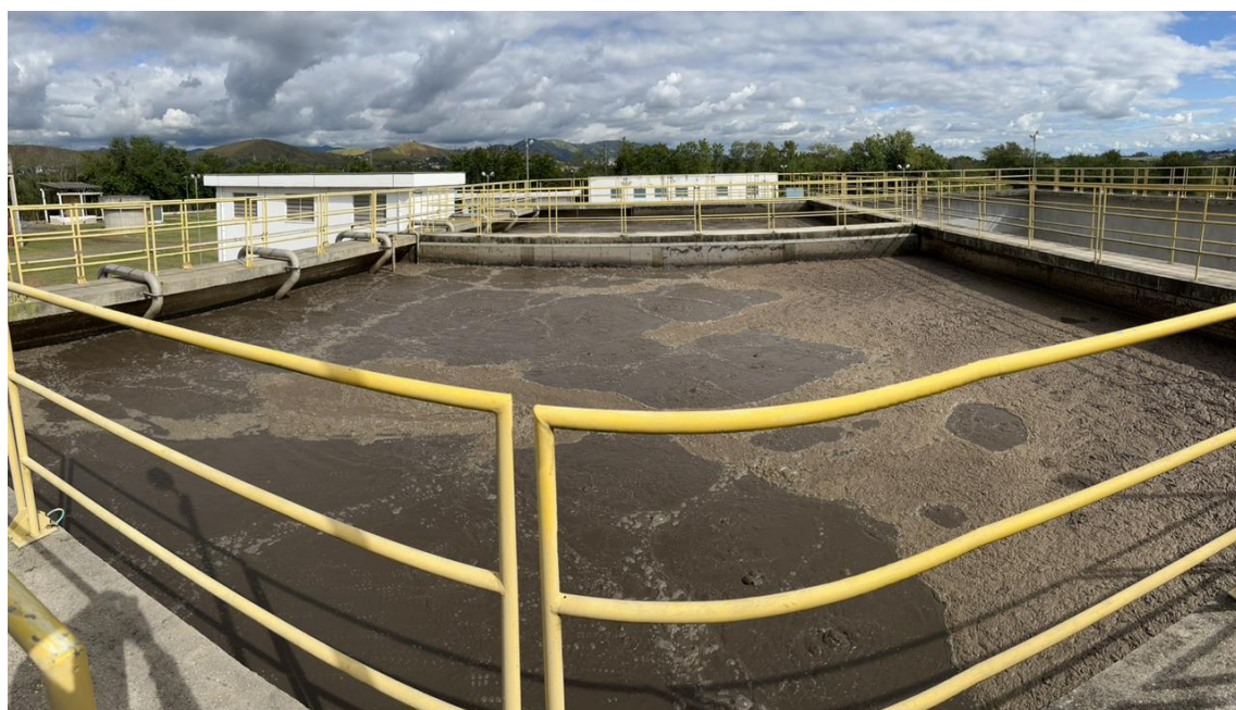
Figura 10: Visão geral Tanque de Aeração de Lodo Ativado
